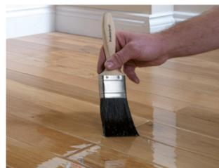
Например, хорошо отшлифовать до ровной гладкой поверхности и обработать затем поверхность сильно разбавленным лаком.
